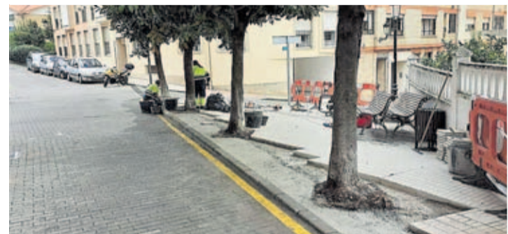
Obras en la calle Doctor Fleming de Candás. | R. P. F.
